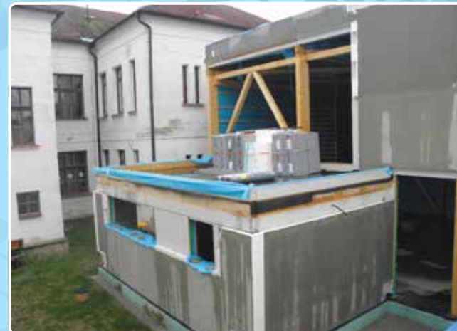
Stavba nové tělocvičny zdárně pokračuje.
